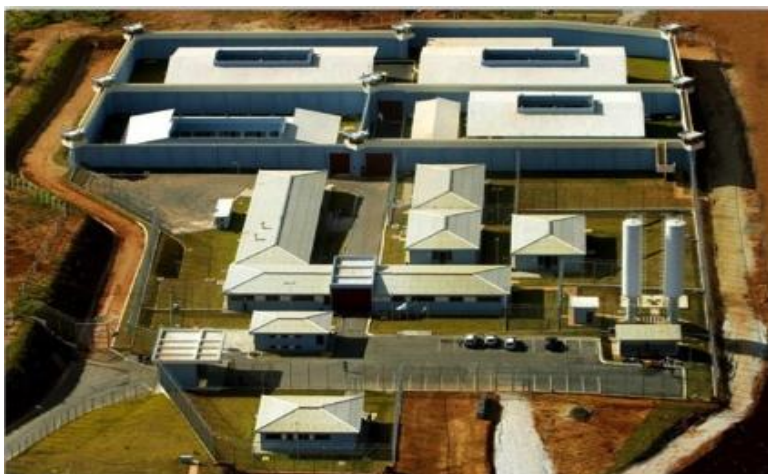
Figura 2 Imagem aérea da penitenciária em foco: ao fundo, do lado esquerdo, pavilhão fechado 1; lado direito, pavilhão fechado 2; ao centro, pavilhão feminino e à direita, pavilhão semiaberto. As construções menores referem-se ao refeitório (para funcionários), área destinada à saúde e prédios administrativos
