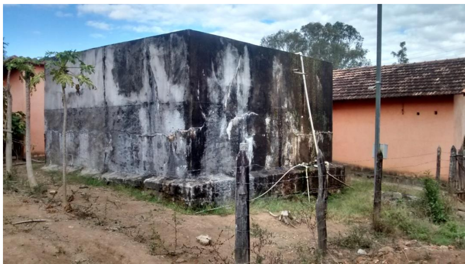
Figura 9 Reservatório de abastecimento de água
