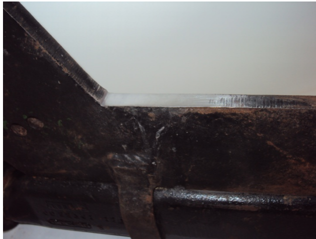
Figura 19 Superfície preparada para colagem dos extensômetros
