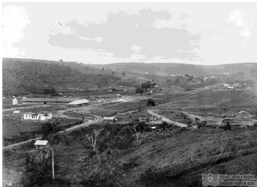
Início das obras de construção da ESAV, década de 1920
