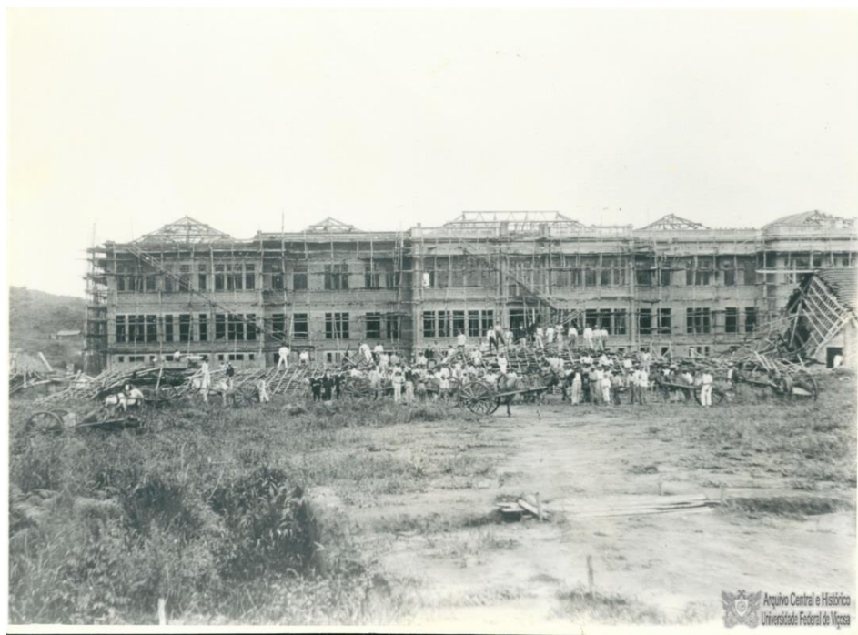
Prédio Principal em construção, década de 1920
