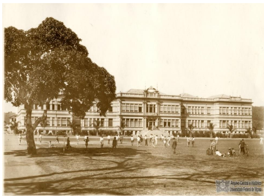
Paineira e Prédio Principal, década de 1930
