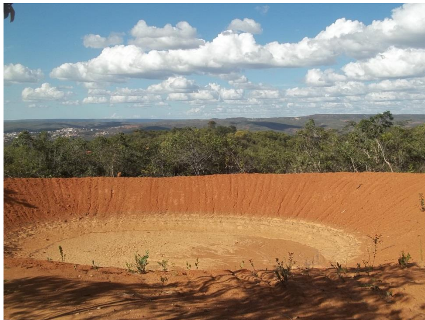
Figura 3 – Barragem após infiltração da água de chuva Fonte: Do autor (2016)
