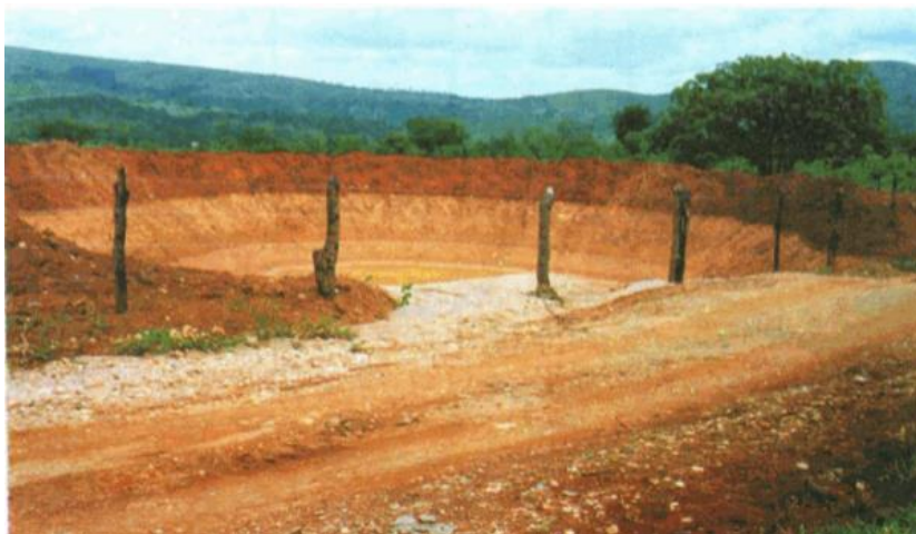
Figura 17 Barragem após infiltração. Fonte: Barros (2000).
