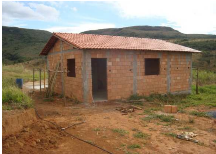
Figura 7A Casa em construção, em um dos lotes
