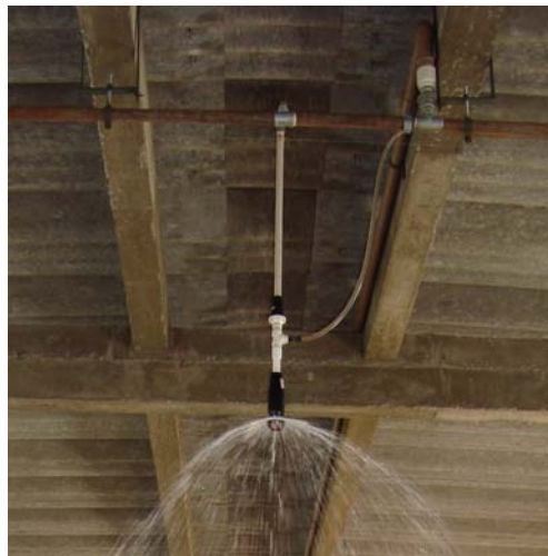
FIGURA 6 Emissor Quad-Spray conectado a tubulação lateral suspensa.
