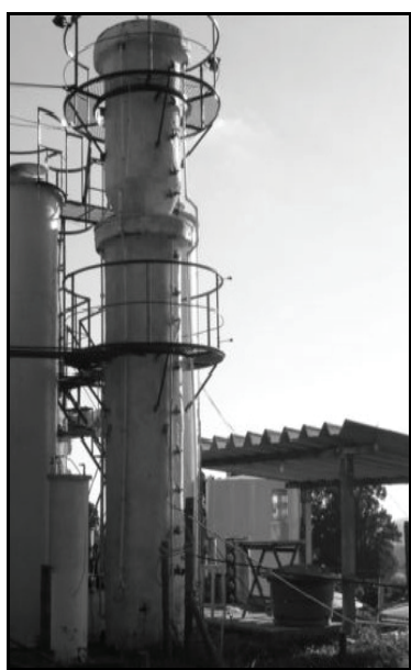
Figura 1. Reator UASB concêntrico: (a) Vista parcial - (b) corte longitudinal (medidas em centímetros).
