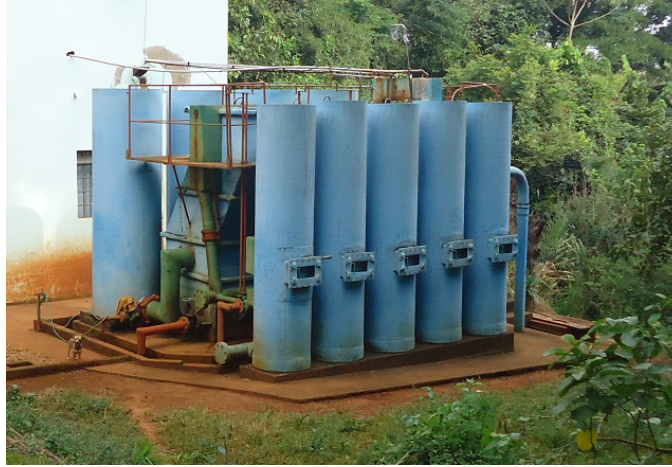
Figura 1.7 – Estação de tratamento de água Benedito Tibúrcio Barbosa, localizada no campus da Universidade Federal de Lavras, com capacidade para tratar aproximadamente 540 \text{ L min}^{-1} .
