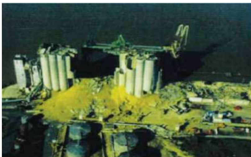
Figura 4 Imagem após explosão nos silos. Blaye, França 1997 Fonte: Rangel (2007)
