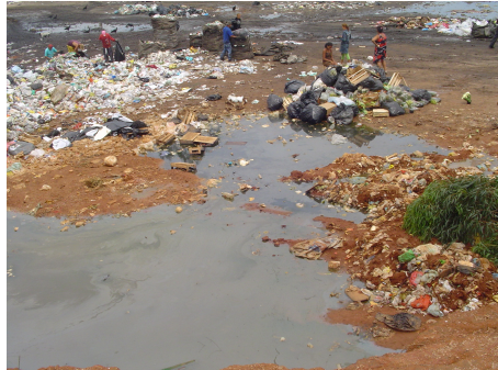
FIGURA 6: Acúmulo de chorume na COOPER-ET. Fonte: Imagens das visitas de campo
