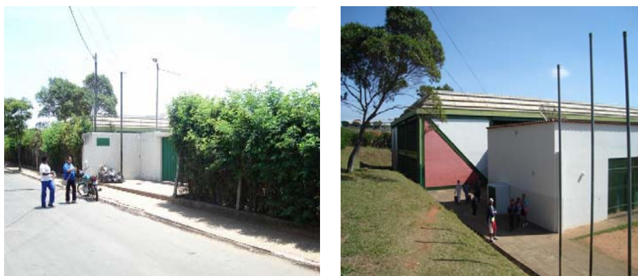
FIGURA 1 Vista parcial da fachada e do prédio da Escola Estadual Cinira Carvalho. Lavras, MG. 2007.
