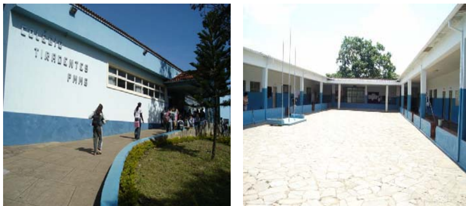
FIGURA 2 Vista parcial da fachada e do prédio da Escola Tiradentes, Lavras, MG, 2007.
