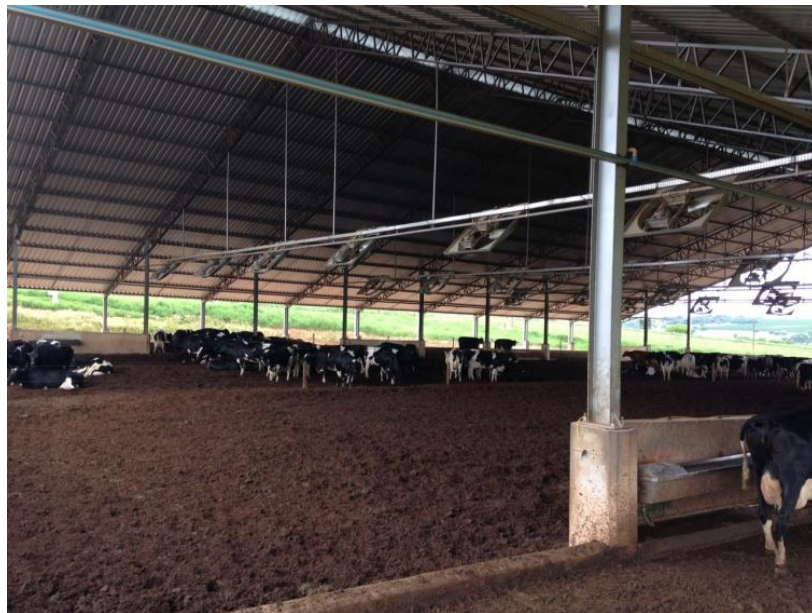
Figura 1 – Disposição dos ventiladores no compost barn
