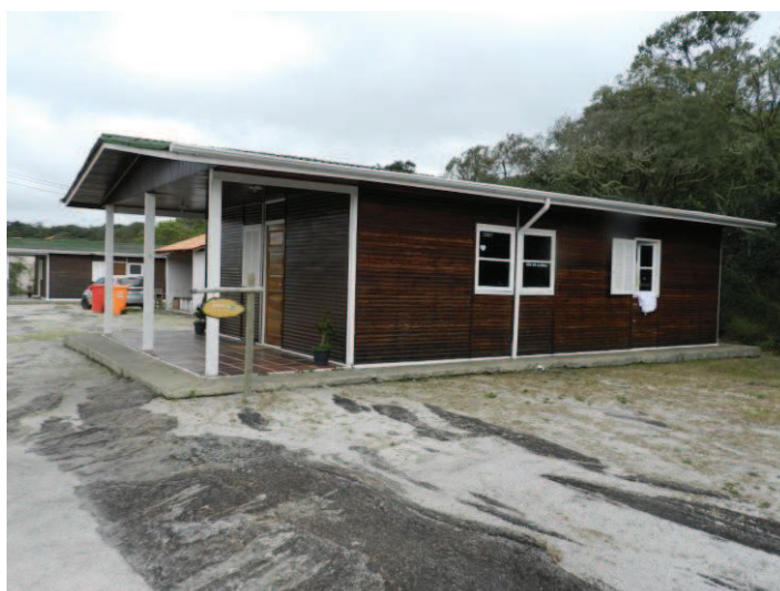
Foto 6 – Estrutura de “Alojamentos”.
