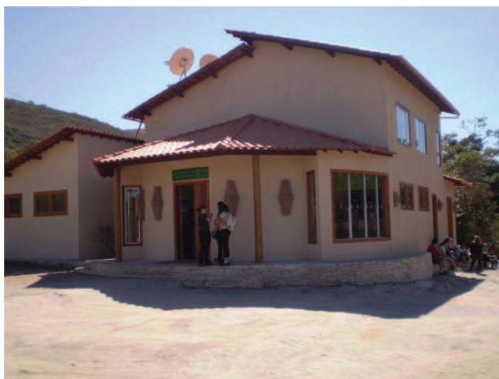
Foto 5 – Estrutura do “Centro de Visitantes”.
