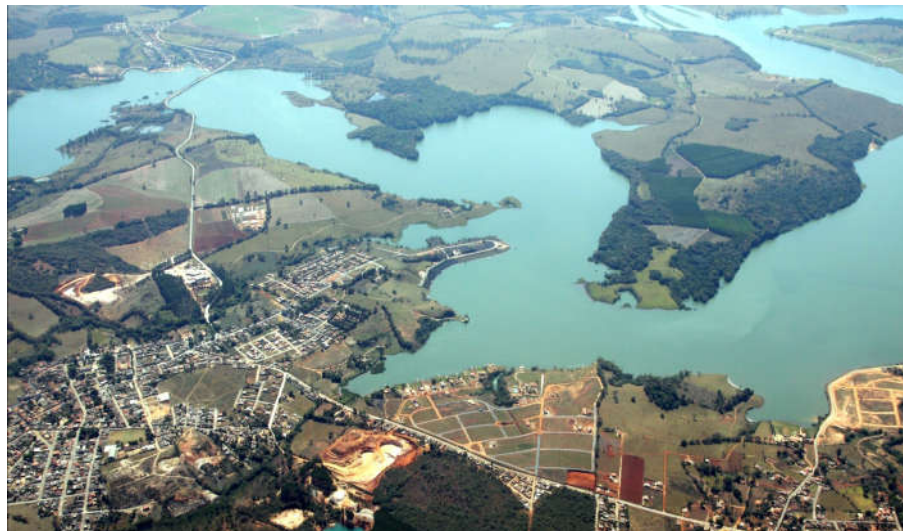
Figura 3 – Reservatório do Funil, no trecho próximo à sede municipal de Ijaci.
