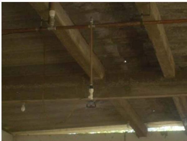
Figura 5 Emissor Super Spray (*Senninger Irrigation*) conectados à tubulação lateral suspensa
