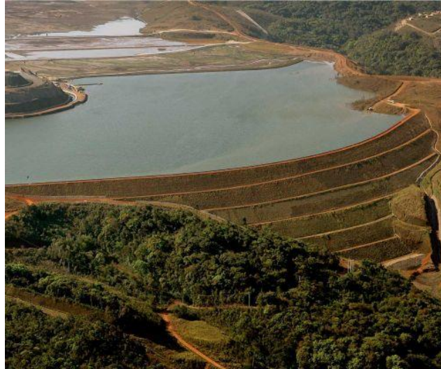
Figura 13- Barragem de rejeito de mineração.
