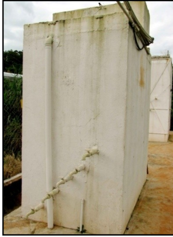
FIGURA 18 Reator RAMAL/UASB da estação experimental, em primeiro plano, mostrando os registros para amostragem do perfil lodo.
