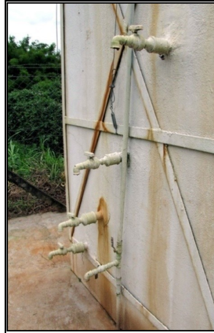
FIGURA 15 Lateral externa do RAC, mostrando os quatro amostradores.
