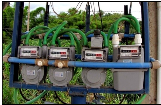
FIGURA 20 Gasômetros (da esquerda para a direita: RAC – compartimentos 1, 2 e 3 do e reator RAMAL/UASB).
