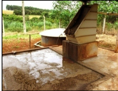
FIGURA 9 Peneira estática em funcionamento. Detalhe do leito de drenagem e, ao fundo, o tanque de equalização e acidificação (TAE).
