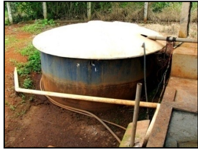
FIGURA 10 Tanque de acidificação e equalização (TAE), em vista lateral.
