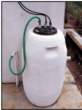
FIGURA 19 Equalizador de pressão do biogás gerado (contêiner plástico de 200 litros).
