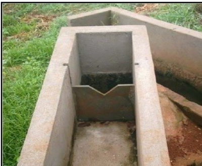
FIGURA 6 Caixa de areia, detalhe para o vertedor triangular tipo Thompson.
