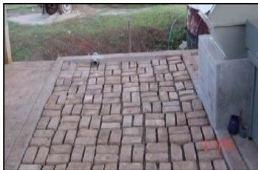
FIGURA 8 Leito de drenagem da peneira estática.
