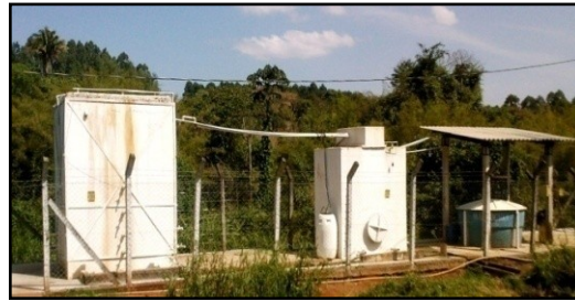
FIGURA 13 Sistema de tratamento anaeróbico RAC e UASB.
