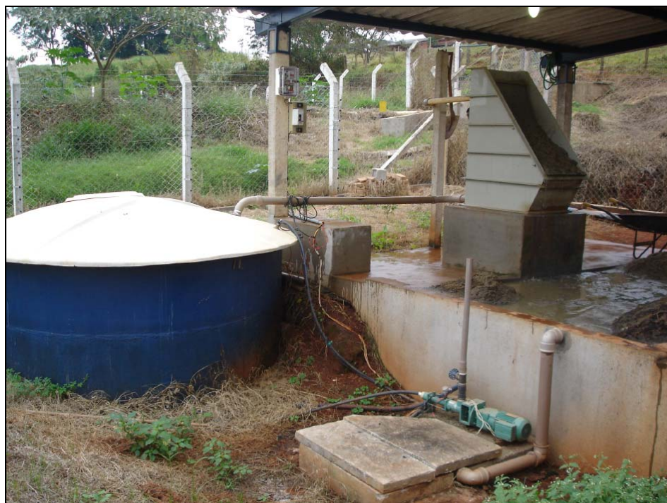
FIGURA 16 Sistema de separação de dejetos por meio de peneira estacionária instalada no Setor de Suinocultura da UFLA
