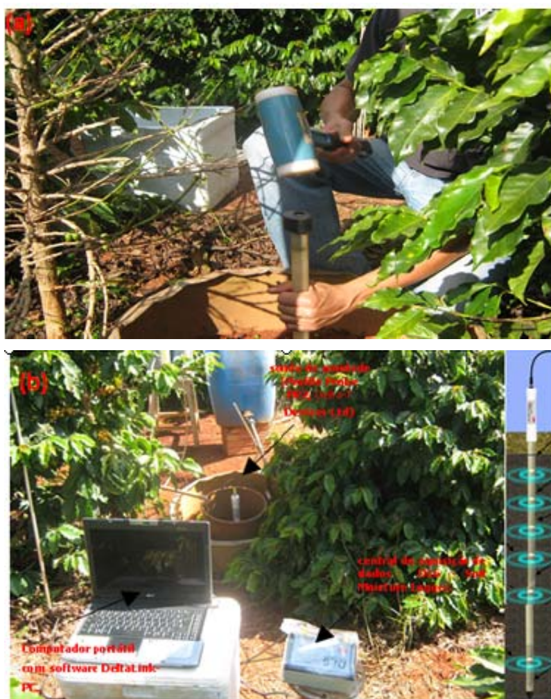
Figura 4 Instalação do tubo de acesso (a), equipamentos utilizados e representação esquemática da FDR e seus sensores (b)
