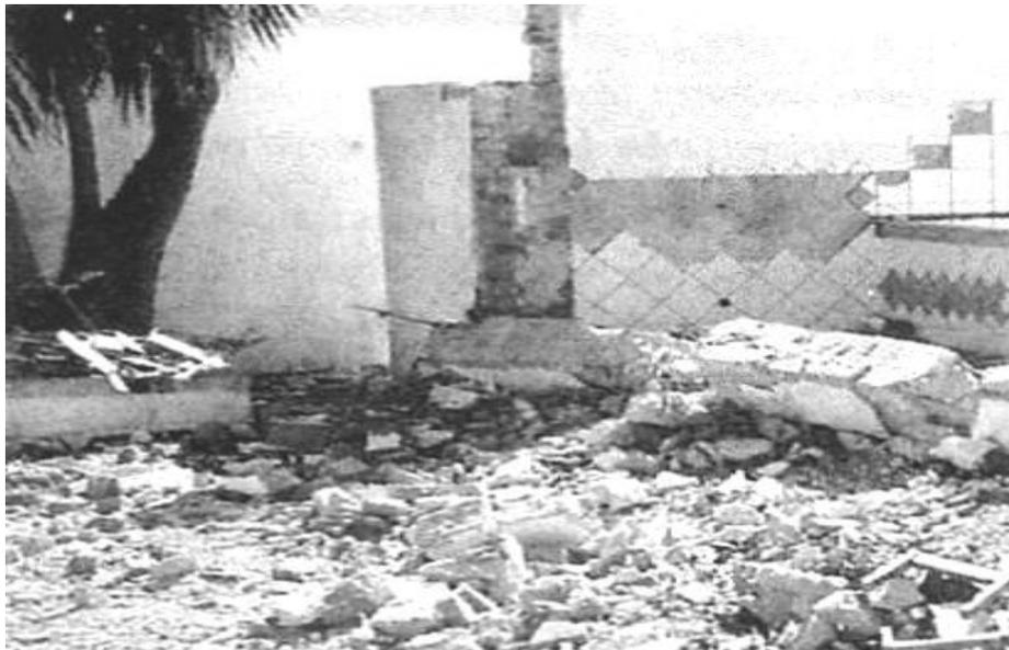
FIGURA 2 - Mistura de componentes construtivos do resíduo de construção e demolição pela ausência de gestão em demolições
