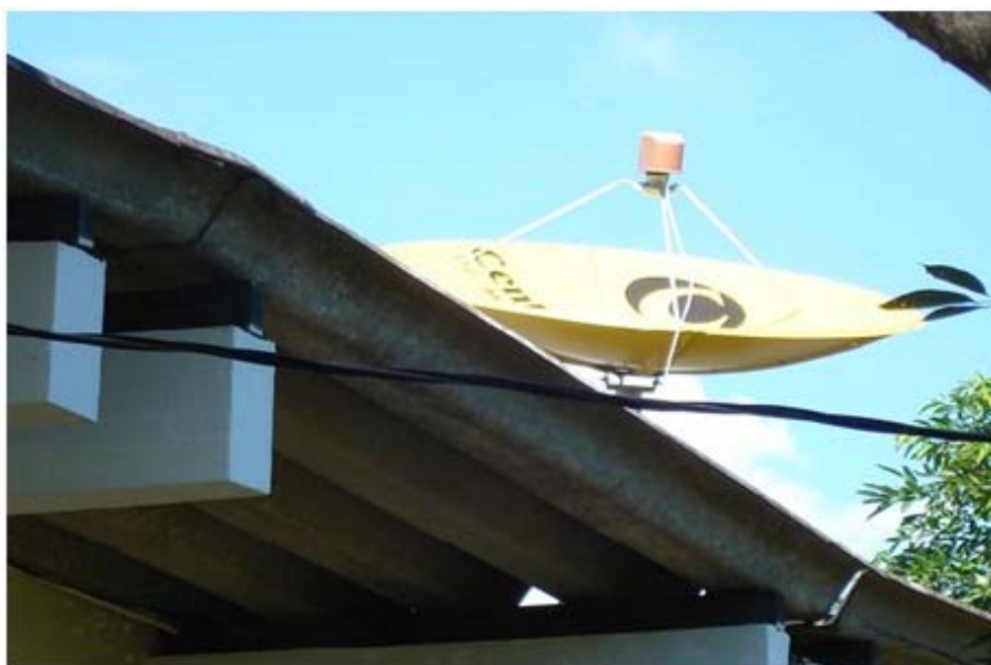
FIGURA 6 Antena utilizada para recebimento dos dados do satélite Meteosat, situada no Departamento de Engenharia da Universidade Federal de Lavras (DEG/UFLA).
