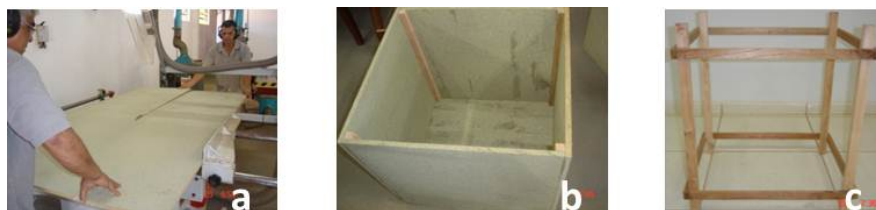
Figura 9 montagem dos módulos; a) corte dos painéis; b) módulo; c) suporte
