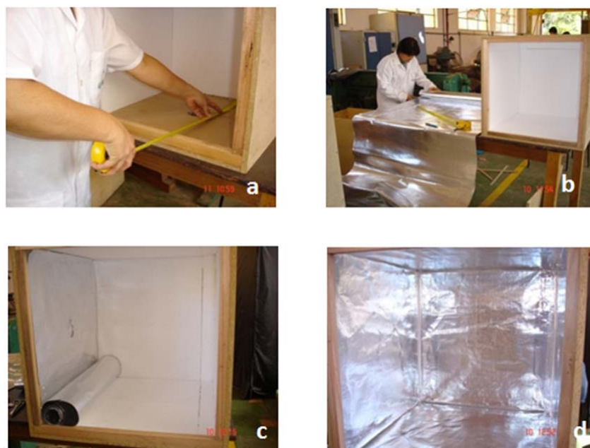
Figura 10 Revestimento dos módulos; a) com isopor e (b, c, d) da manta aluminizada
