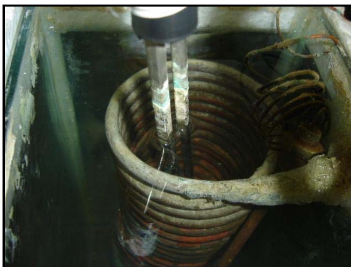
FIGURA 2A Sistema de aquecimento
