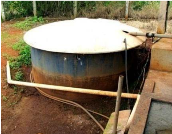
Figura 22 Vista parcial do TAE
