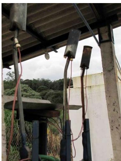
Figura 36 Queimador de biogás
