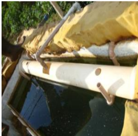
Figura 40 Calha de distribuição instalada na parte superior da primeira câmara do RAC
