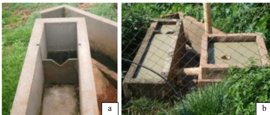
Figura 19 (a) Caixa de areia (desarenador) como vertedor triangular tipo Thompson; (b) Caixa de passagem para decantação dos sólidos com tubulação de captação superficial
