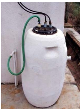
Figura 34 Equalizador de pressão do biogás proveniente do reator UASB
