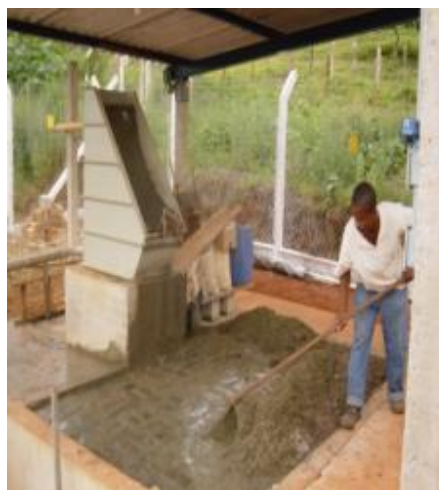
Figura 21 Leito de drenagem (LD)
