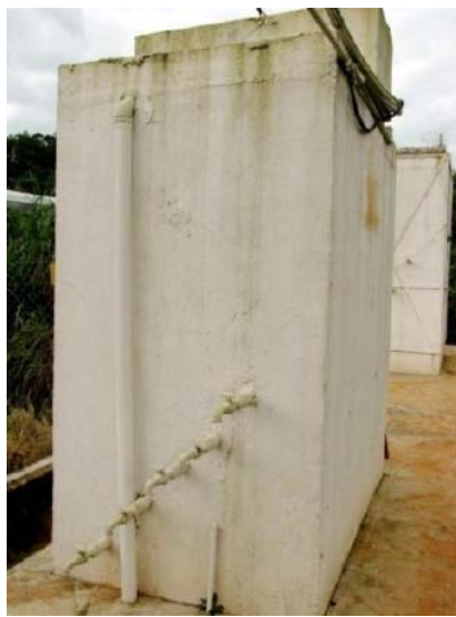
Figura 32 Vista dos amostradores para a coleta do lodo no UASB
