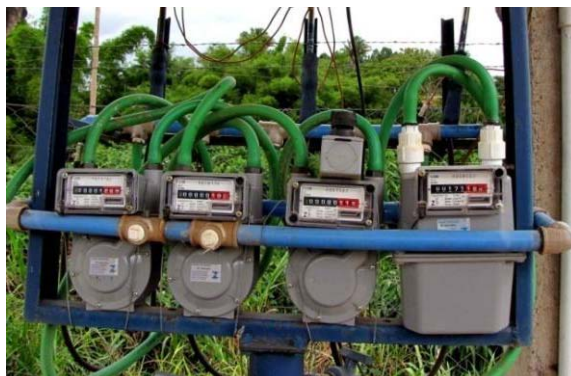
Figura 35 Gasômetros sendo 1º, 2º, e 3º para os compartimentos do RAC e o 4º para UASB
