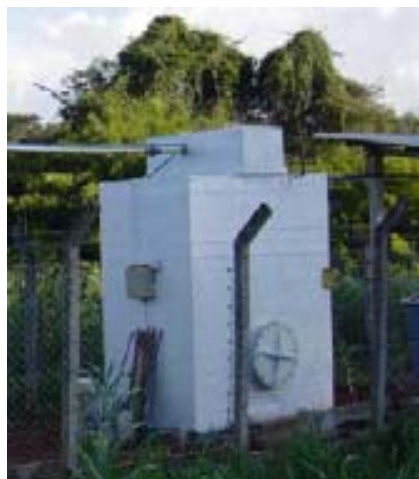
Figura 33 Vista geral do reator UASB
