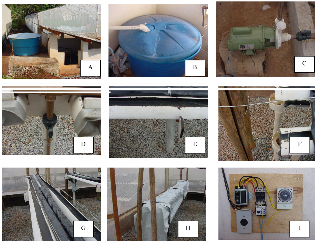
FIGURA 9: Detalhes do sistema de hidroponia desenvolvido para a produção tubérculos pré-básicos de batata. A) Visão geral da hidroponia, mostrado reservatório de reposição de água (1000 L) e casa de bomba; B) Reservatório para solução nutritiva (2000 L), locado dentro da casa de bomba, abaixo do nível do solo; C) Conjunto moto-bomba (0,5 cv de potência), revestida de PVC , locada dentro da casa de bomba; D) Detalhe de cada conjunto, mostrando registro para controle individual do fluxo de solução em cada bancada; E) Detalhe dos suportes para as canaletas; F) Detalhe das canaletas e tubulação de retorno da solução nutritiva; G) Visão geral das canaletas (4m de comprimento cada) e arames utilizados no tutoramento das plantas; H) Detalhe de cada conjunto mostrando a bancada com as canaletas cobertas com plástico dupla face e os mourões utilizados no tutoramento; I) Detalhe da chave geral que aciona o sistema e o timer, que controla o período de bombeamento da solução nutritiva para as canaletas. UFLA, Lavras-MG, 2005.
