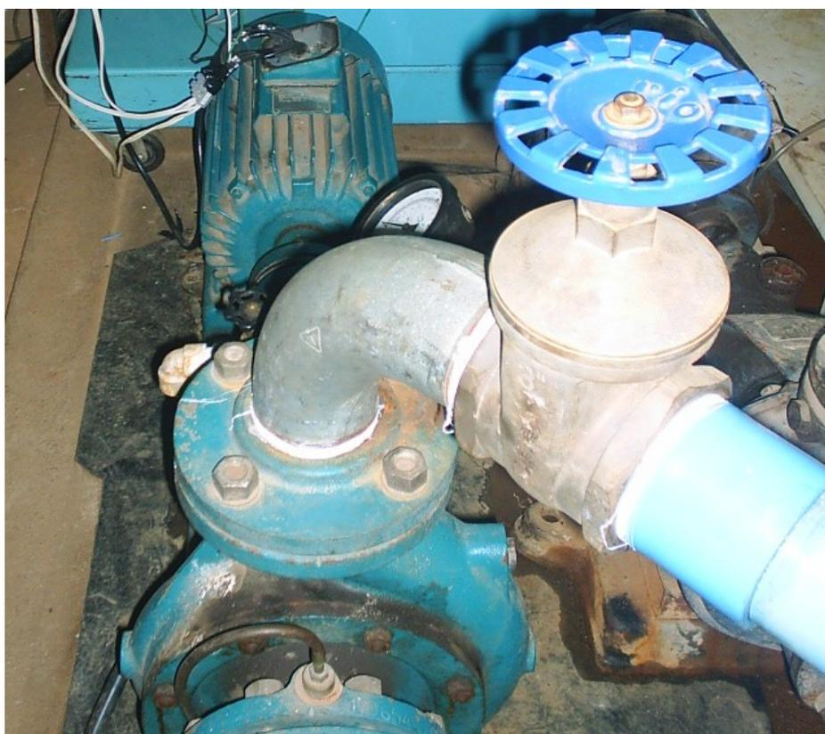
**FIGURA 8** Válvula instalada na entrada da BFT. Laboratório de Hidráulica da UFLA, Lavras, MG, 2006.
