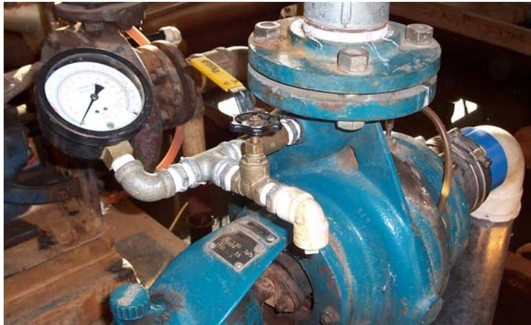
**FIGURA 19** Manômetro instalado na entrada de água da BFT.
