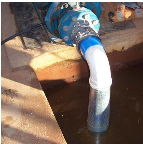
**FIGURA 9** Tubo cônico utilizado para a restituição de água na saída da BFT, Laboratório de Hidráulica da UFLA, Lavras, MG, 2006.
