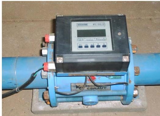
**FIGURA 20** Medidor de vazão instalado na tubulação de adução.
