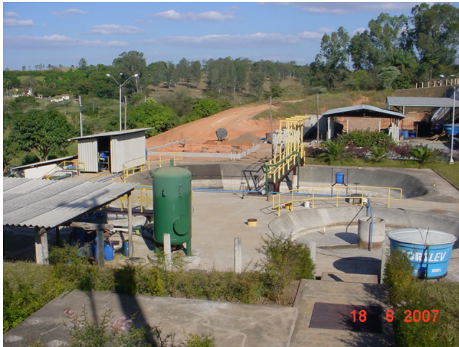
FIGURA 5. Vista parcial da estação de tratamento de efluentes da Gelatinas Indústria & Comércio Ltda.
