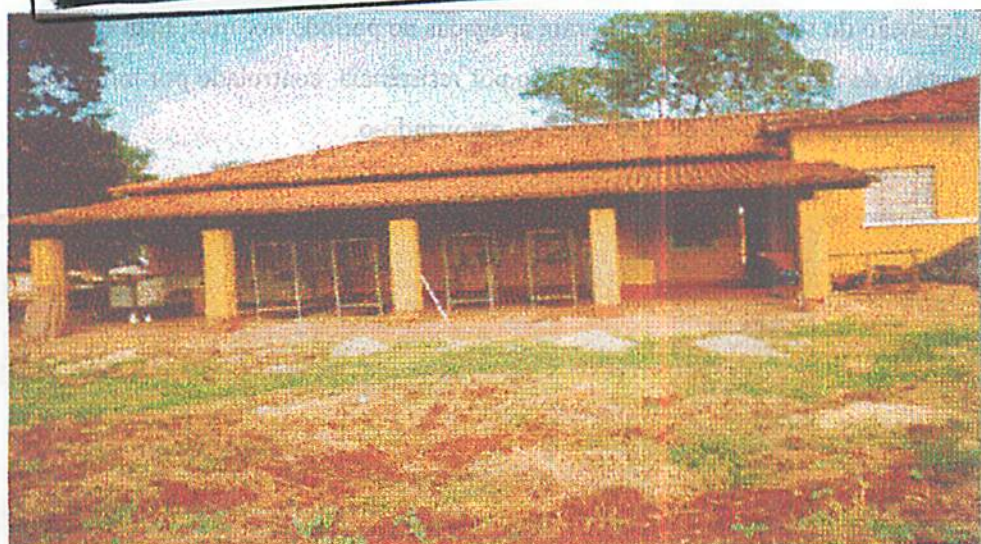
FIGURA 4. Vista panorâmica do galpão.
