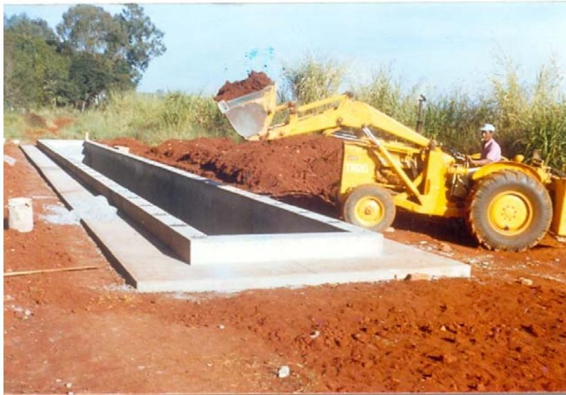
Figura 5 Retroescavadeira realizando operação de retorno do solo desestruturado à caixa de solo. Observa-se a estrutura em alvenaria para recebimento do solo, protegendo-o contra possível contaminação
