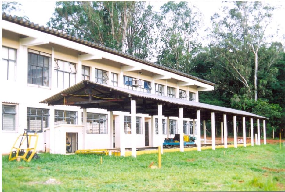
Figura 6 Vista longitudinal da caixa de solo, mostrando pilares em alvenaria, tesouras em madeira e cobertura de fibro cimento
