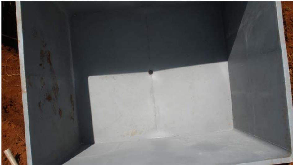
Figura 3 Detalhe do formato piramidal do fundo do tanque
