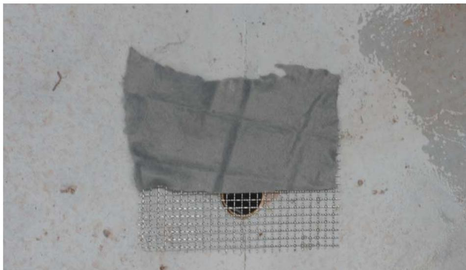
Figura 5 Detalhe da tubulação de saída do tanque sendo sobreposta pela grade e pela manta sintética
