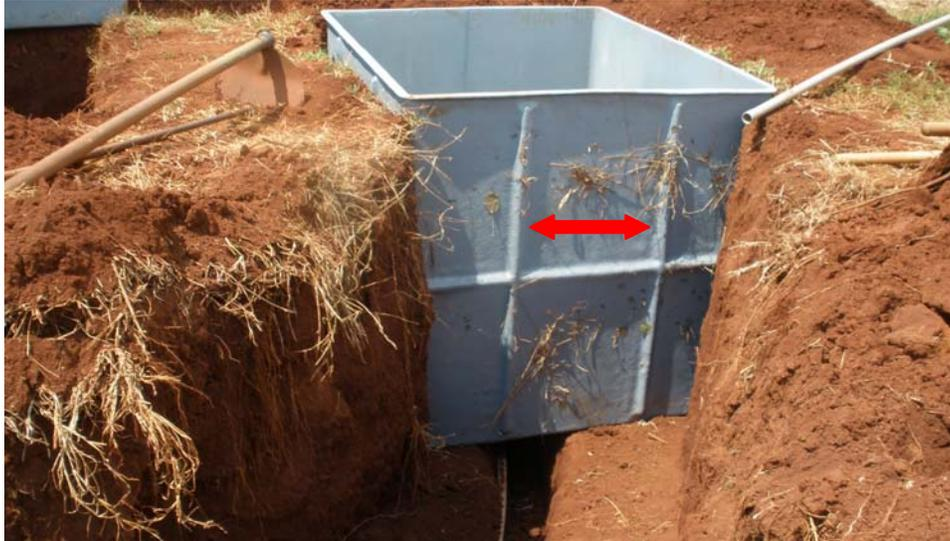
Figura 4 Detalhe das barras de ferro nas paredes laterais do tanque
