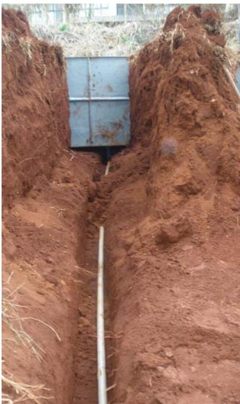
Figura 7 Detalhe da instalação da tubulação de drenagem dos tanques em área experimental de plantio de mamoneira
