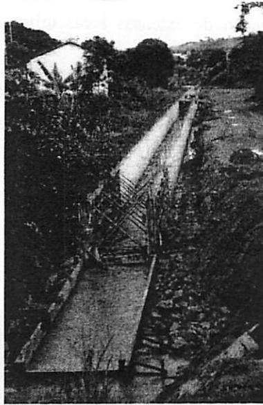
FIGURA 2 Canal em concreto armado sendo construído no córrego do Centenário, no município de Lavras, MG
