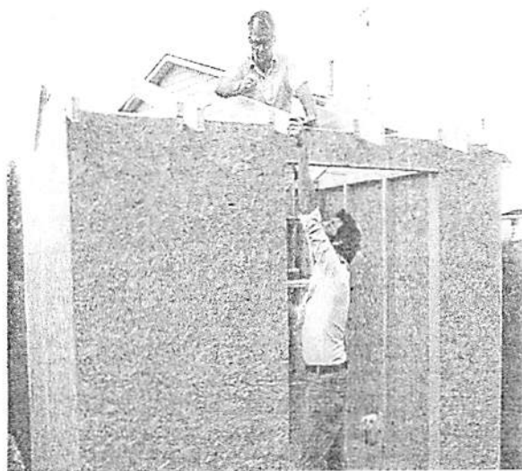
FIGURA 3 – Aplicação do OSB na construção civil (Masisa, 2004).
