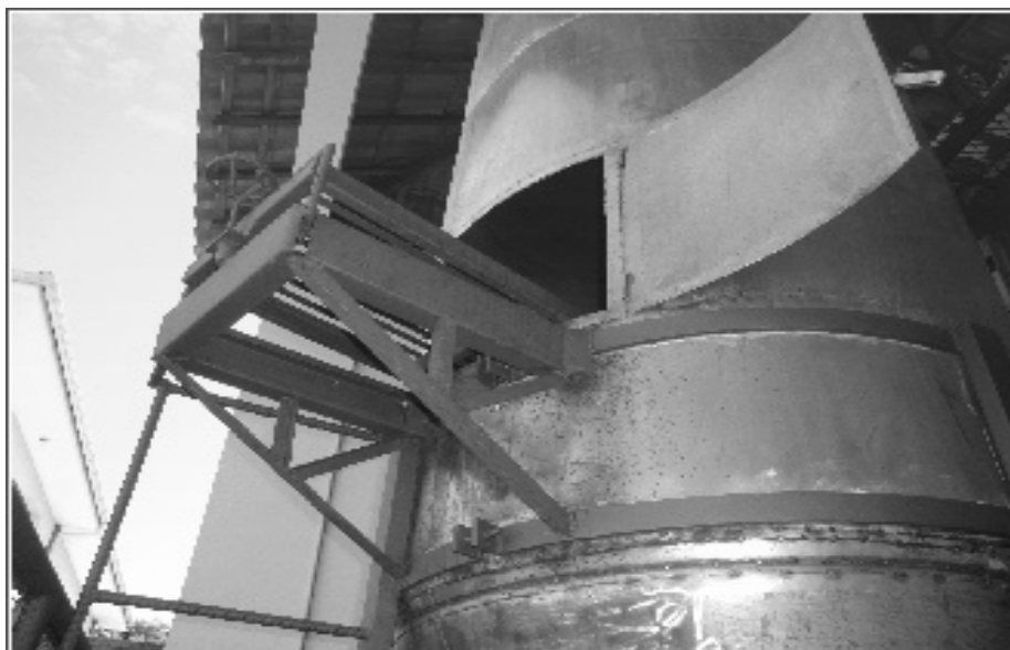
Figura 40 Porta de acesso à câmara de secagem
