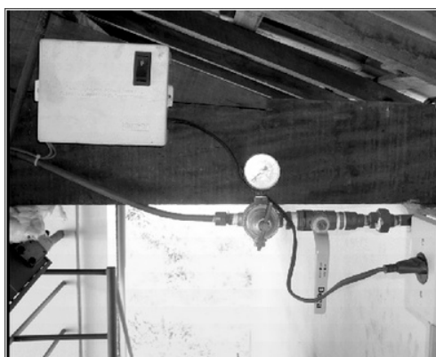
Figura 45 Sistema de centelhamento elétrico e válvula do gás
