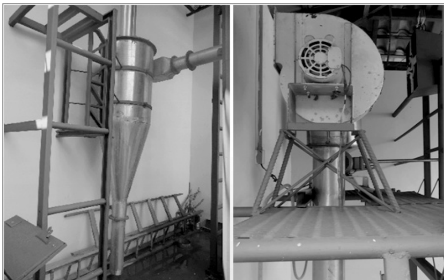
Figura 43 Ciclone (à esquerda) e exaustor (à esquerda)
