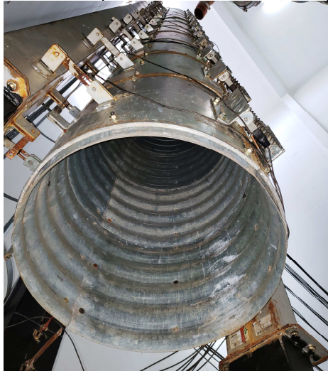
Figura 52 - Vista interna do silo piloto revestido com chapa metálica ondulada.
