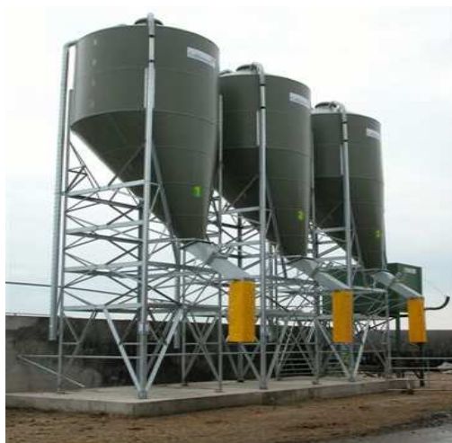
c) Silo elevado. Fonte: Madrona (2008).
