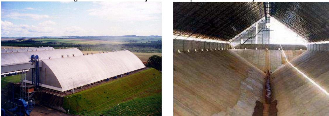
a) Silo horizontal subterrâneo: vista geral e vista interna. Fonte: Gomes (2000).
