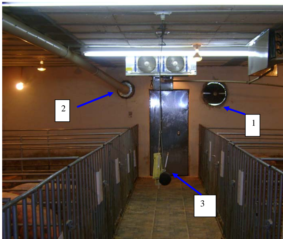
Figura 4 Equipamentos (1- exaustor maior; 2- ventilador com tubo perfurado; 3- termômetros)
