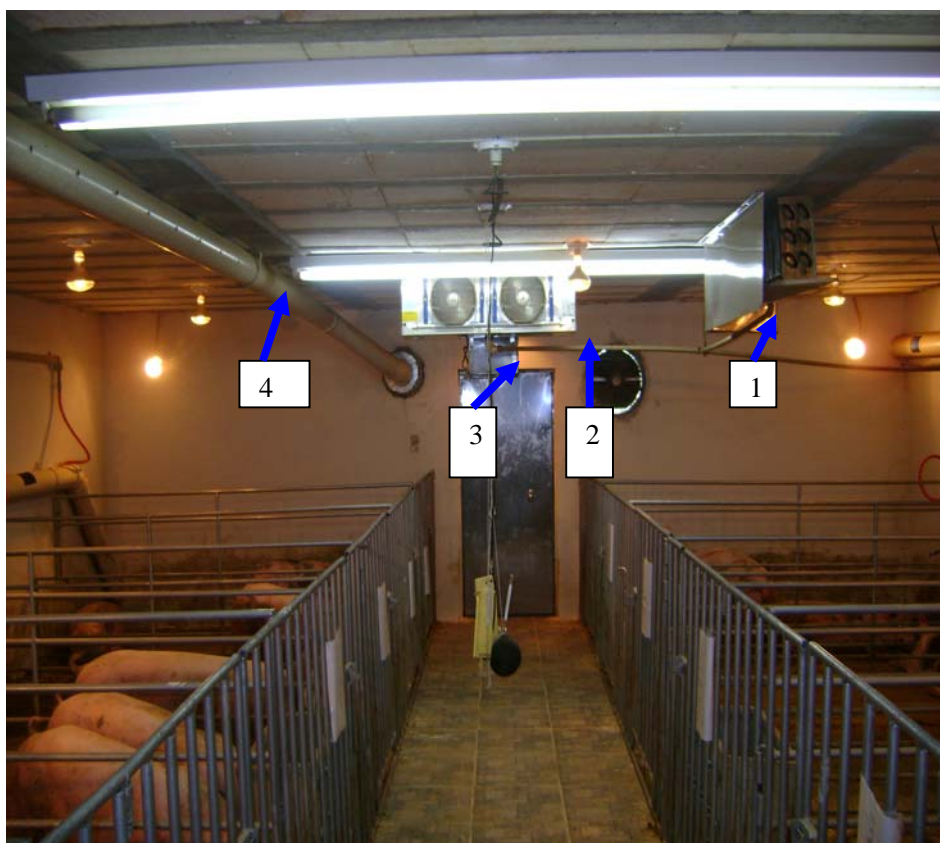
Figura 2 Fotos da sala climatizada ( 1-Desumidificador; 2-Aquecedor e refrigerador ; 3 – Umidificador e 4-Tubo perfurado de ventilação)
