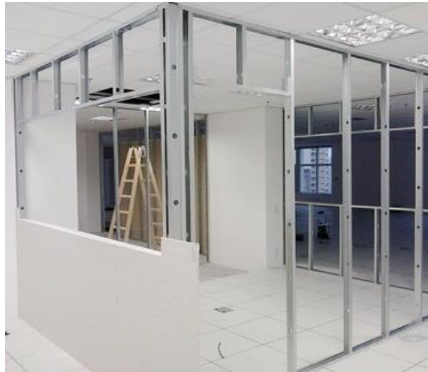
Figura 1 - Paredes divisórias de drywall.
