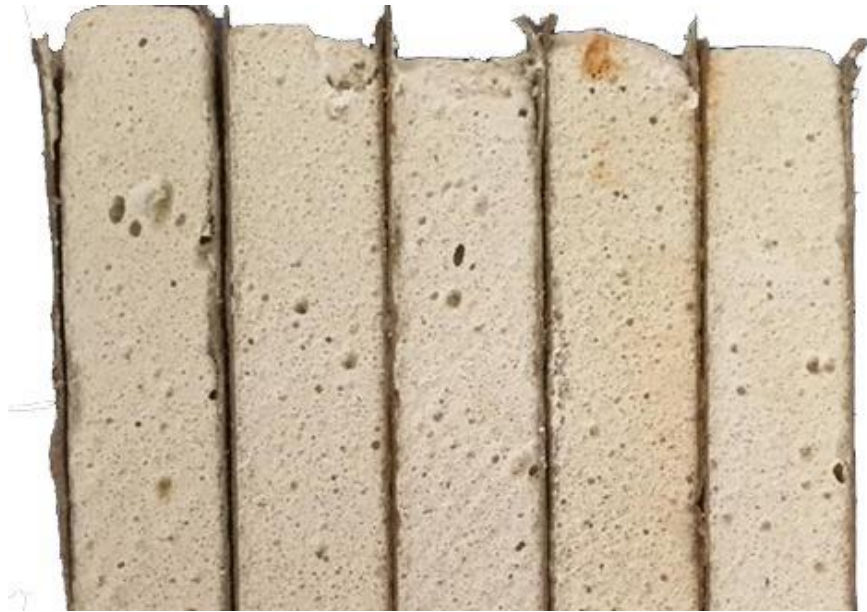
Figura 8 – Descolamento das faces dos painéis de drywall.
