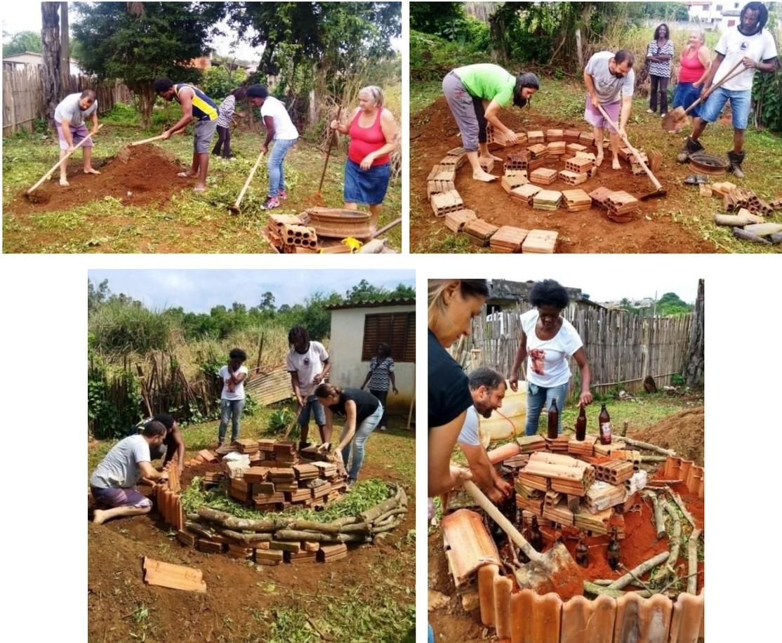
Legenda: Utilização de material encontrado no local e de garrafas enterradas, para a retenção de umidade nos canteiros.
