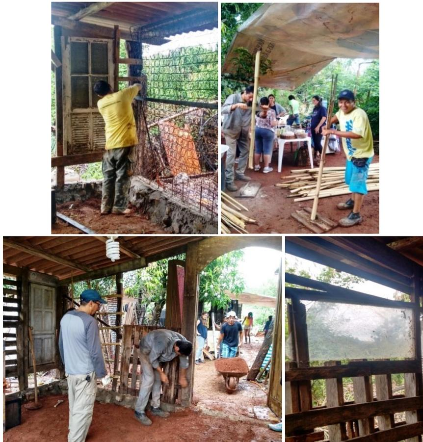
Legenda: Foram utilizados diferentes materiais de reaproveitamento para fixar o gradil de fechamento entre as peças estruturais da parede. Também foram instalados vidros fixos, utilizando-se antigos parabrisas automotivos.
