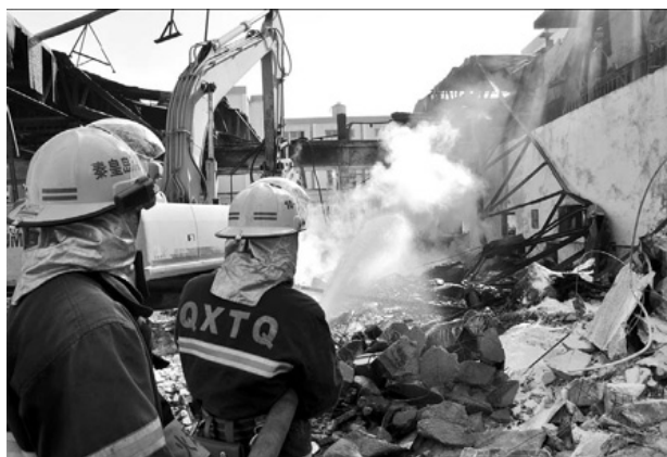
Figura 3 Explosão em Qianhuangdao Lihua Starch Co Ltd na China Fonte: Jie (2010)
