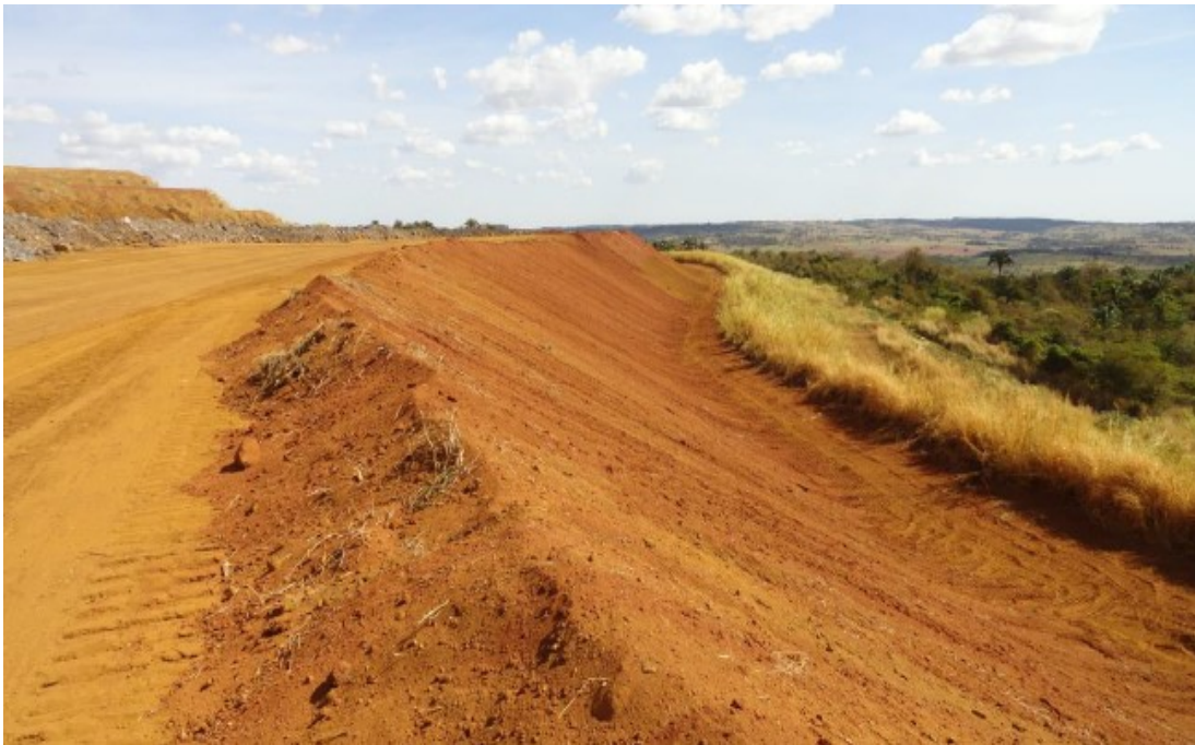
Figura 7: Talude da Pilha de Estéril com aplicação de topsoil . Fonte: Vandeir Toledo.
