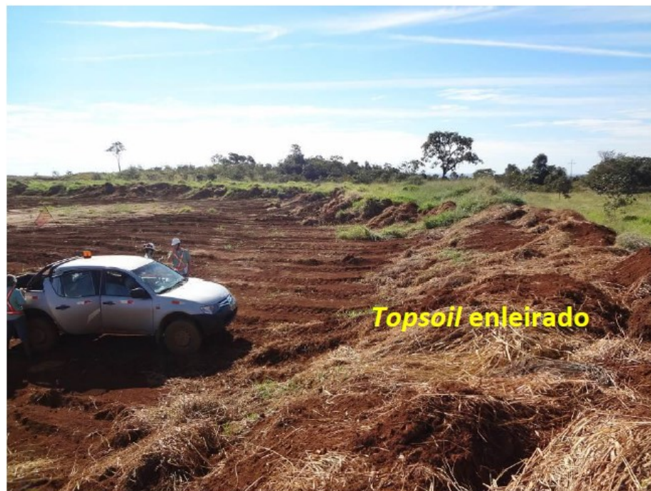
Figura 5: Remoção e enleiramento de topsoil .
