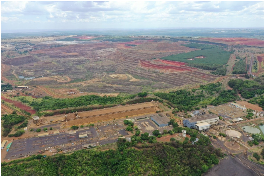
Figura 1 - Foto aérea do Complexo Minerquímico de Catalão.
