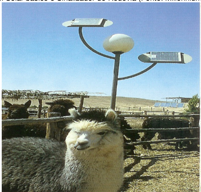
Figura 16 – Iluminação pública, sem fiação (Fonte: Millennium Solar)
