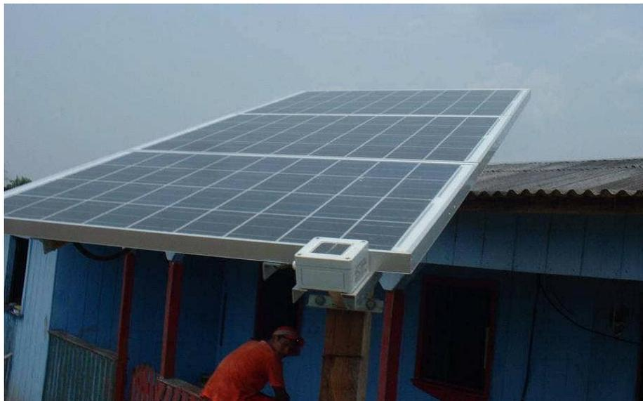
Figura 16 Painel fotovoltaico e sensor de radiação acoplado
