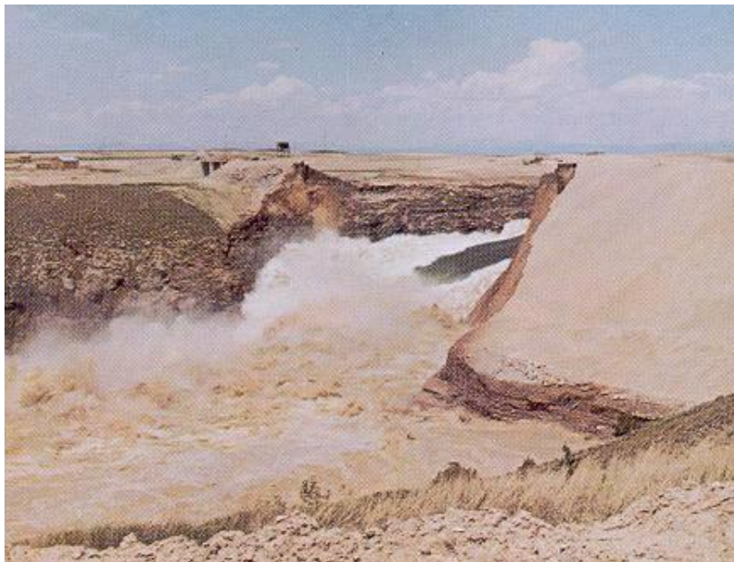
Figura 52- Exemplo de ruptura de barragem de terra
