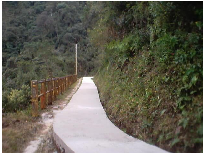
Figura 27- Canal de adução recoberto com laje
