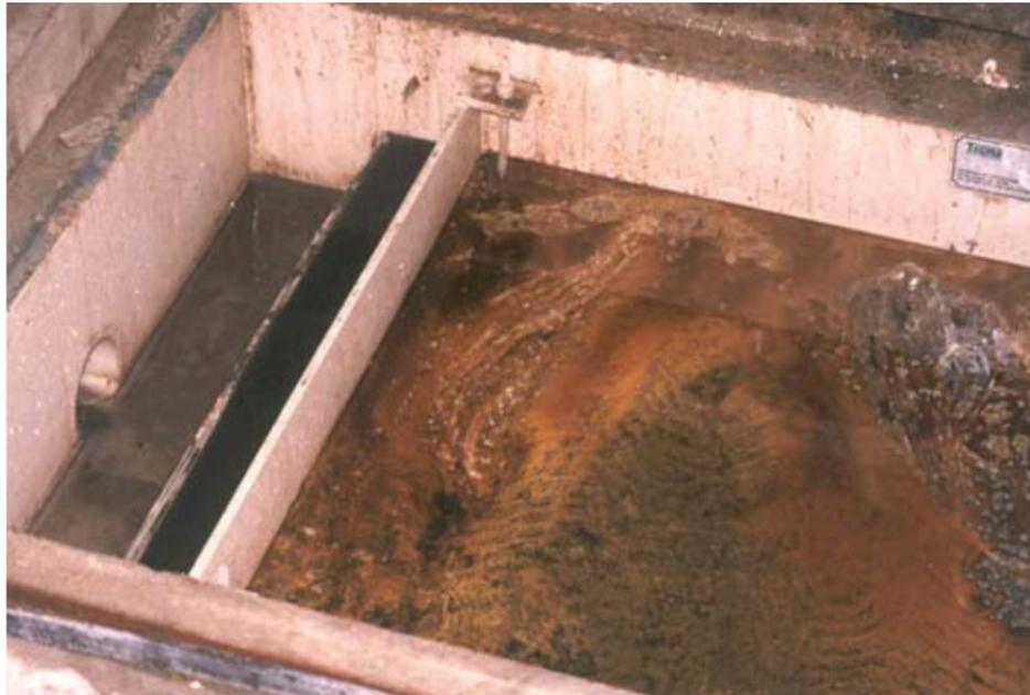
Figura 14 Lodo acumulado nas estações de tratamento de efluentes de indústrias galvânicas
