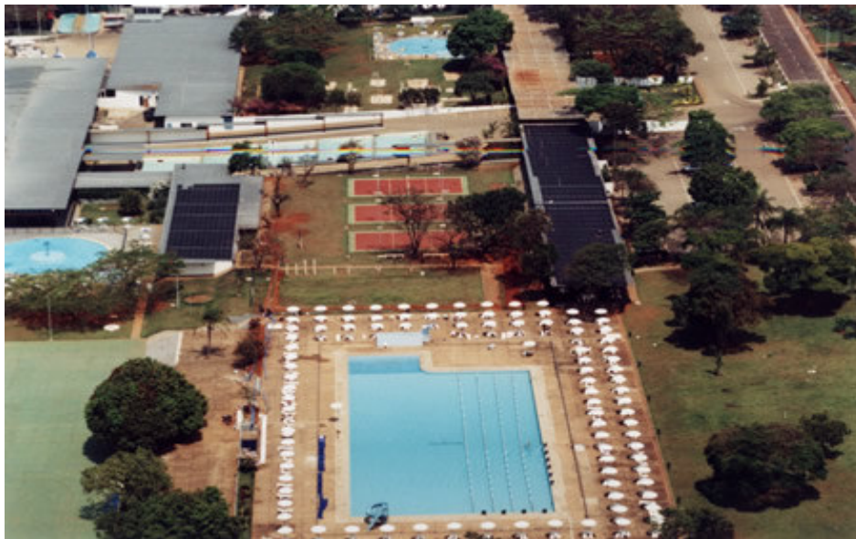
FIGURA 3.2: Aquecimento solar no Clube Naval – Brasília, DF.
