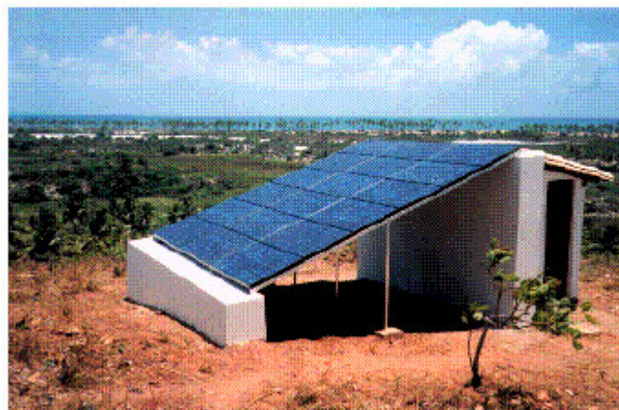
FIGURA 3.13: Aplicação fotovoltaica do Parque Ecológico do Porto de Saúípe - BA.
