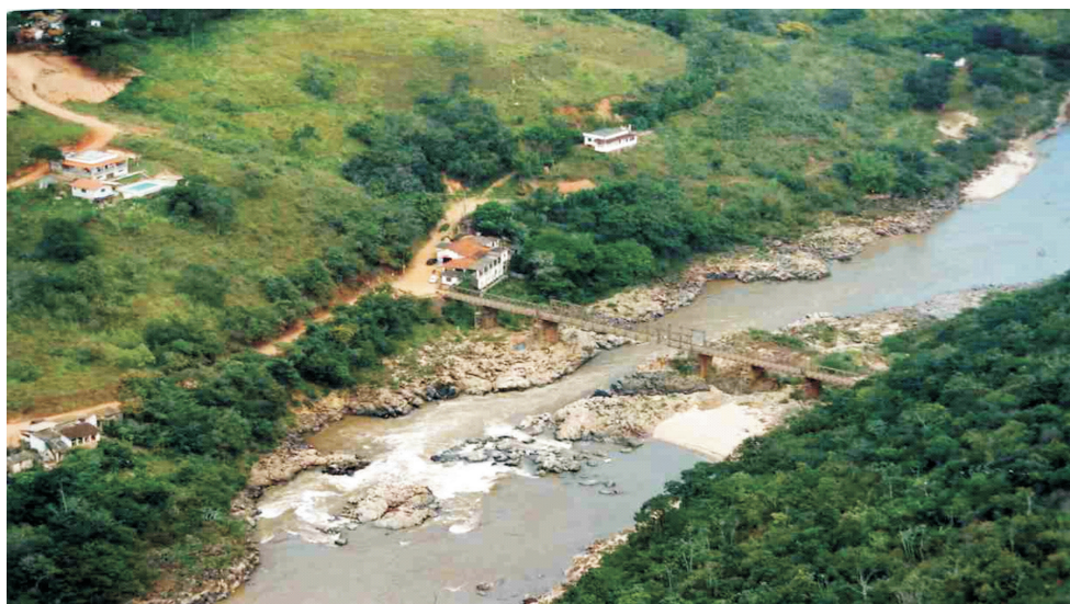
FIGURA 03 - Ponte do Funil, sobre o rio Grande, na divisa entre os municípios de Lavras e Perdões-MG.
