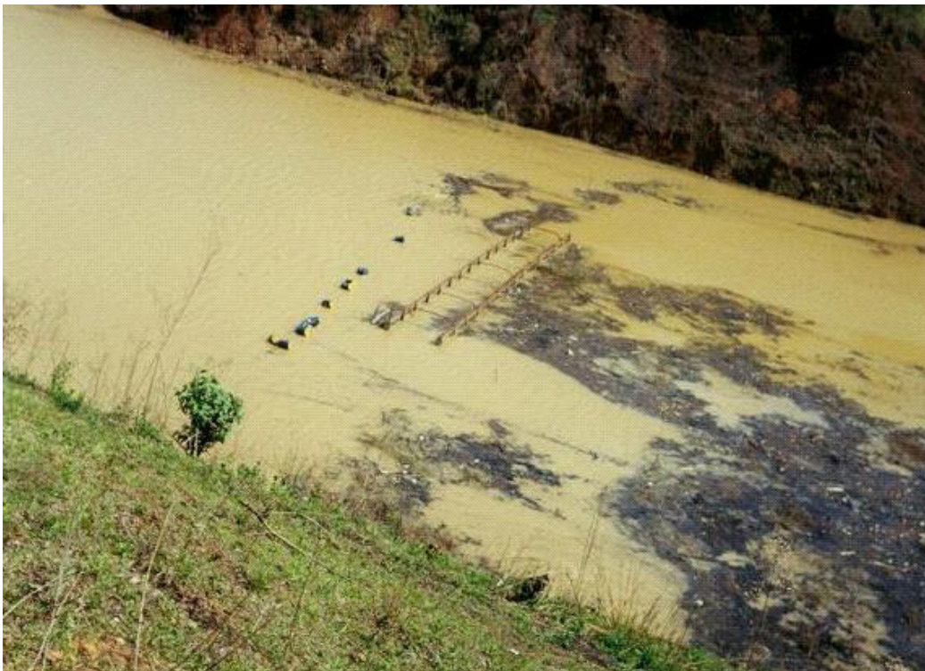
FIGURA 14 - Início do enchimento da barragem com o desaparecimento da ponte do Funil, em Lavras-MG.
