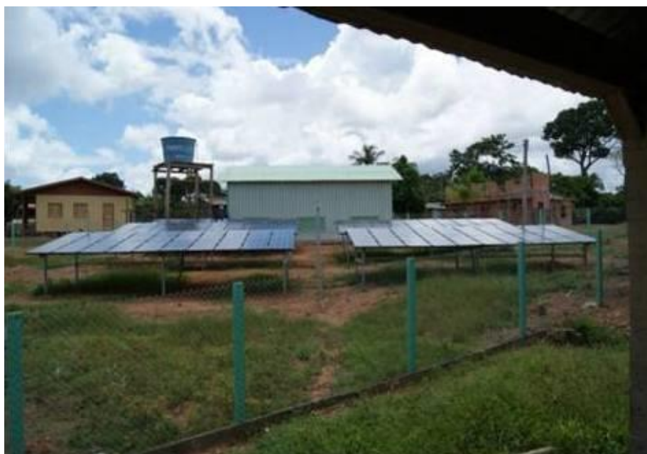
Figura 3 Vista Geral da Mini-rede da Comunidade de Novo Airão em Sobrado Fonte: Amazonas Energia (2011)
