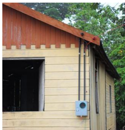
Figura 11 Medidor externo Fonte: Amazonas Energia (2011)
