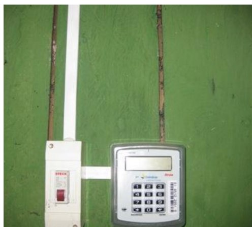
Figura 10 Medidor interno Fonte: Amazonas Energia (2011)
