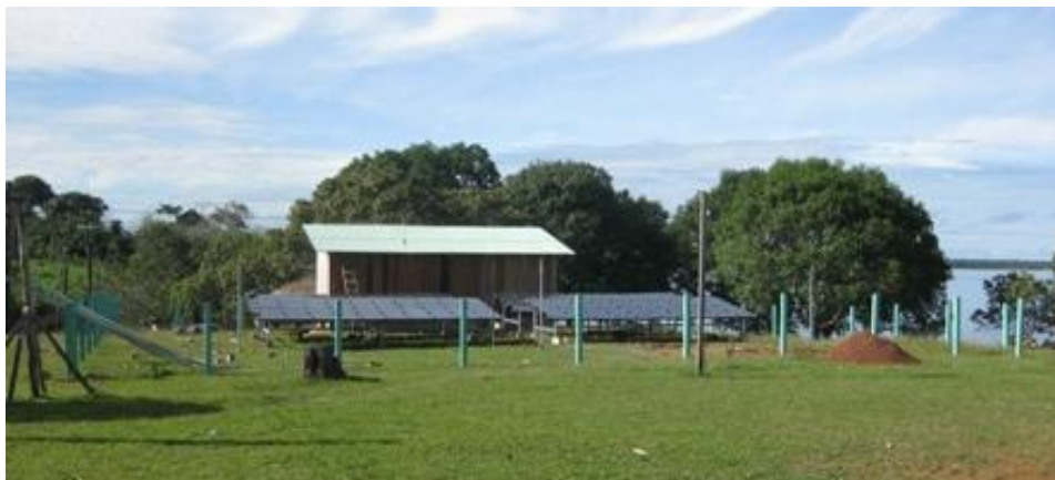
Figura 14 Mini-usina Comunidade Nossa Senhora de Nazaré - Maués Fonte: Guascor (2011)
