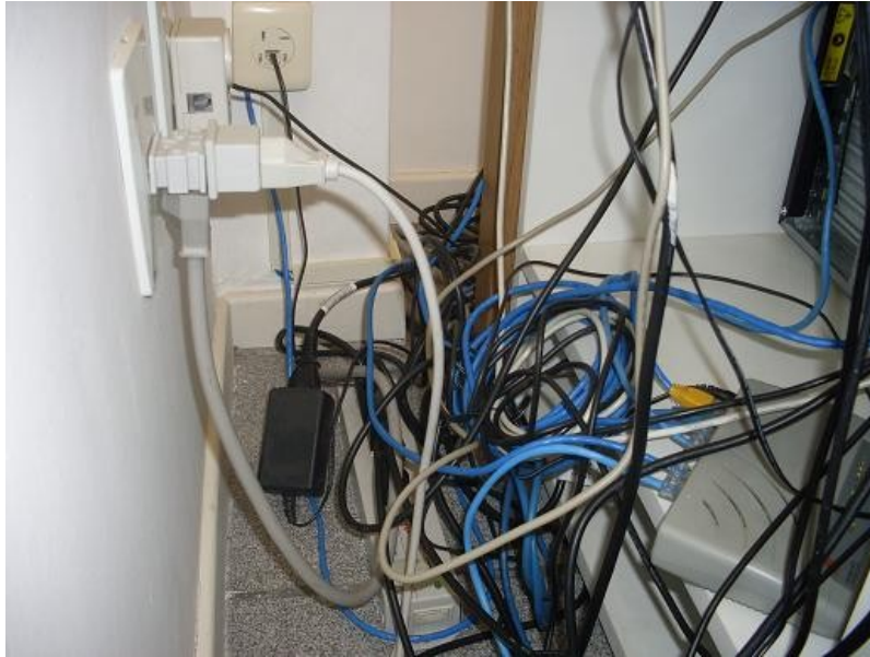
Figura - Cabos de rede de computadores
