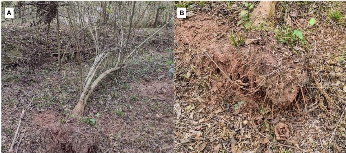
Figura 4 - Queda de árvore em uma área em restauração após seis anos do rompimento da barragem de Fundão e (A) dificuldade do crescimento das raízes em profundidade (B).
