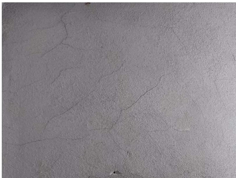
Figura 3: Superfície de reboco com argamassa produzida com a pré-massa
