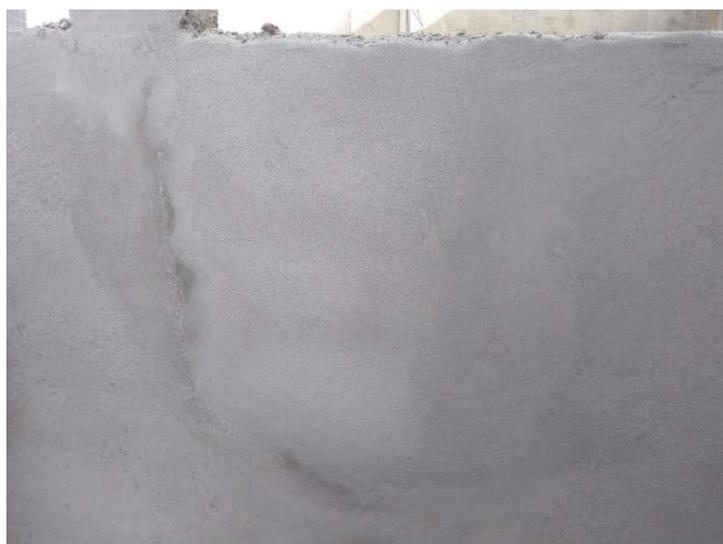
Figura 22: Revestimento com argamassa com 5% fibras kraft
