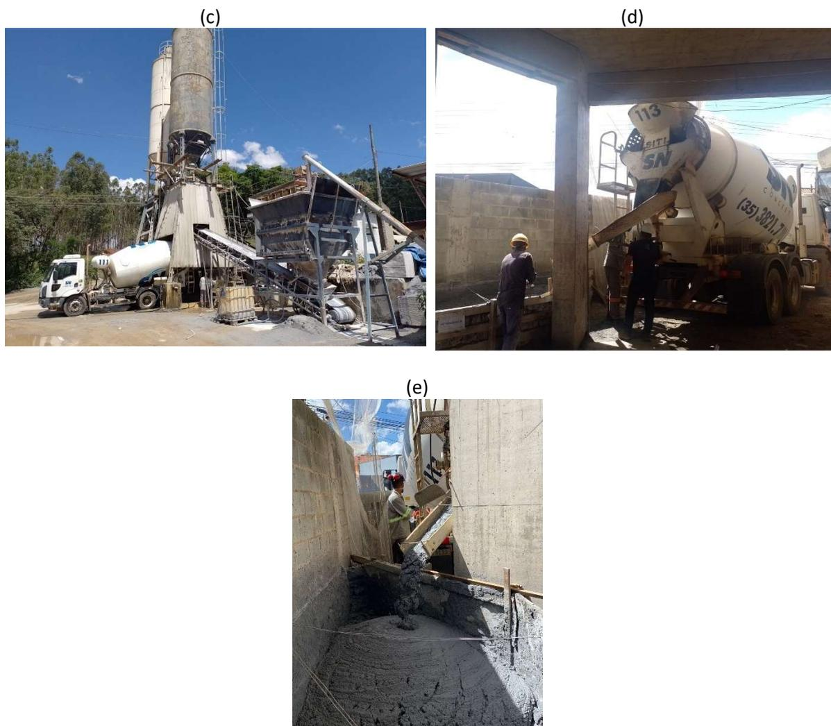
Figura 5: Processo de produção e abastecimento de pré-massa. a) Controle automatizado da produção de pré-massa; b) Dosagem automatiza do traço; c) Abastecimento do caminhão betoneira; d) Abastecimento de pré-massa em obra; e) Armazenamento da pré-massa.
